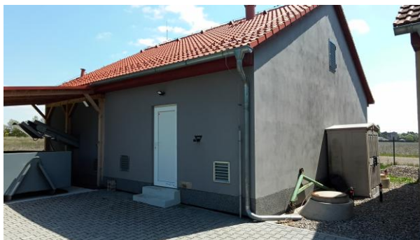
Obrázek 14: Budova objektu – ČOV stará budova
