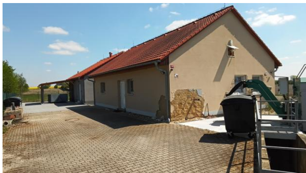
Obrázek 11: Budova objektu – ČOV nová budova
